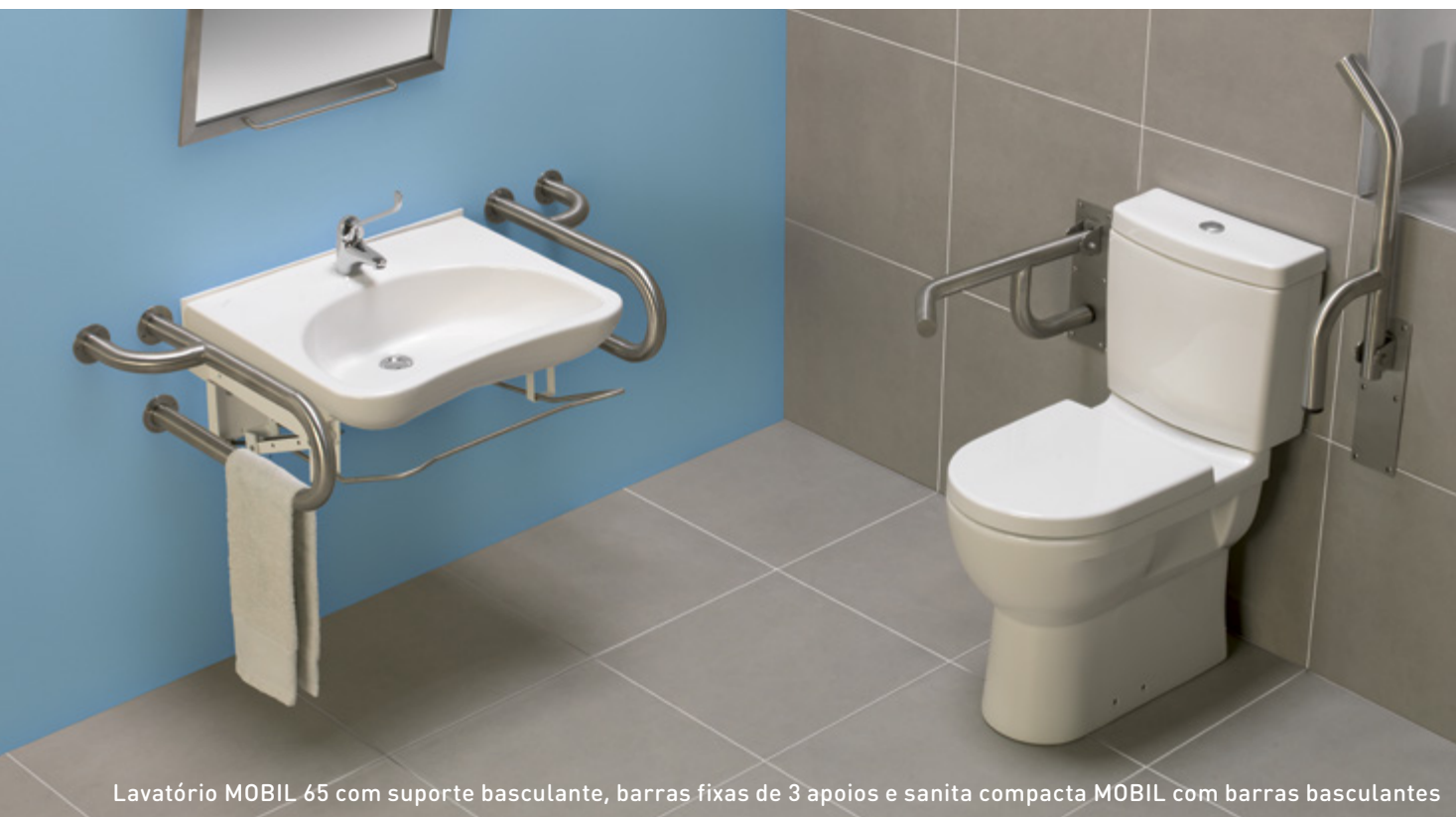
Lavatório MOBIL 65 com suporte basculante aplicado
